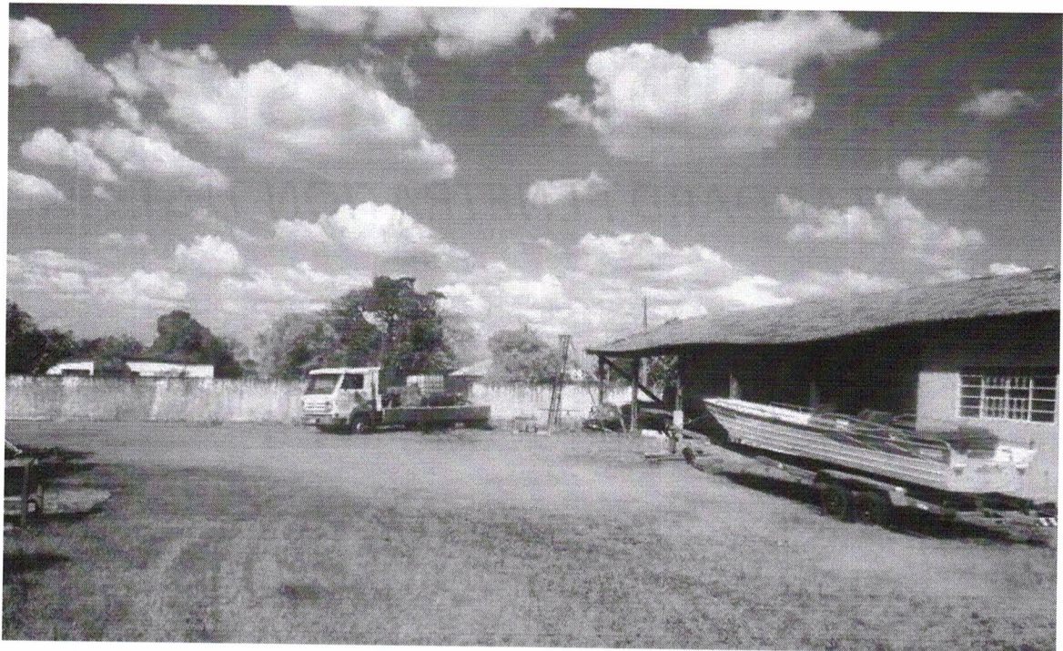
EXECUÇÃO DE SONDAGENS NO LOCAL
